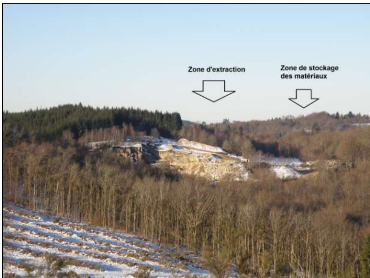
Vue sur le site depuis le sentier de randonnée (grossissement)
